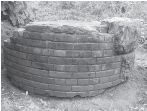
写真8 レンガの状況 (曲面積み)
