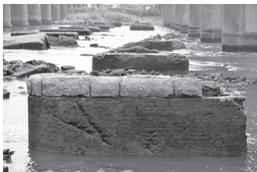
写真 16 相模川内に残存する旧橋脚の一部 (カラー写真別紙)
