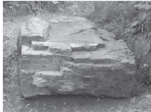
写真6 掘り出した旧橋脚ブロック
