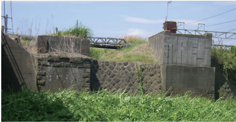
写真3 旧馬入川橋梁の橋台・平塚側 (左)下り線 (右)上り線
