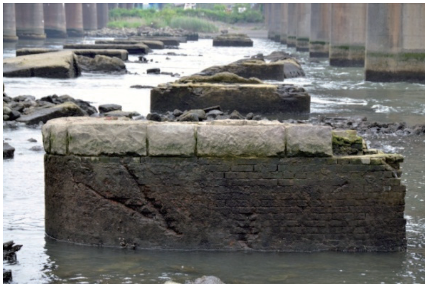
写真16 相模川内に残存する旧橋脚の一部
