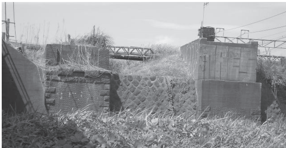
写真3 旧馬入川橋梁の橋台・平塚側
