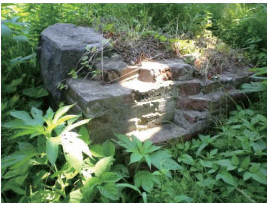
写真5 旧橋脚ブロック発見時の様子
