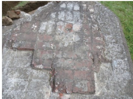
写真15 P-22 上面にはレンガ積みの痕跡がある
