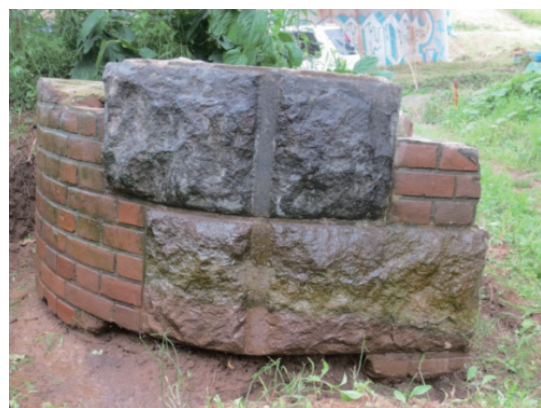
写真7 旧橋脚ブロック石材の加工面
